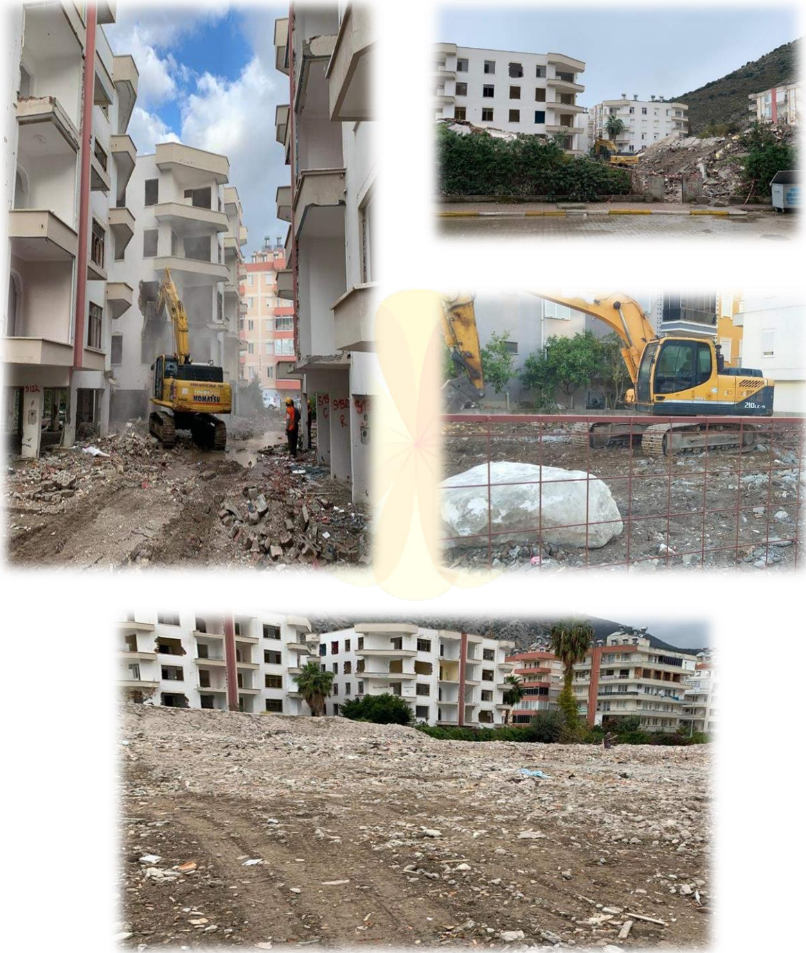
KENTSEL DÖNÜŞÜM İLE İLGİLİ YIKIM
