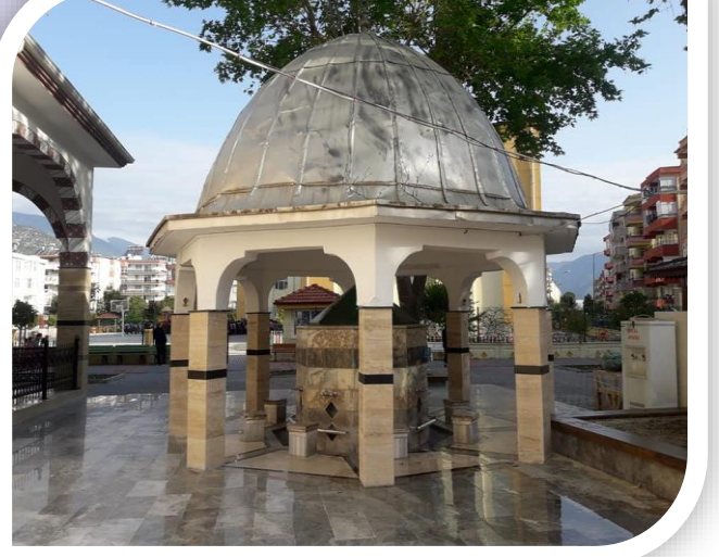
Ayşe Akın Camii
