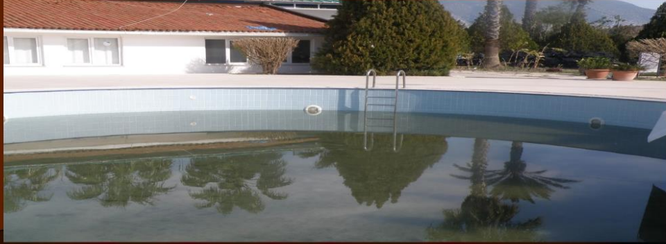
AQUAPARK MEVCUT HAVUZ FAYANSLARININ YENİLENMESİ MALİYET : 1.400,00TL
