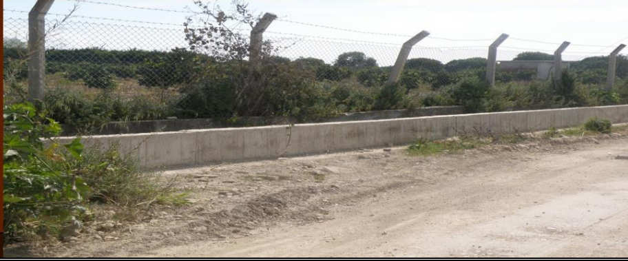
Turunçova mahallesi Akçay Deresi ıslah çalışması
