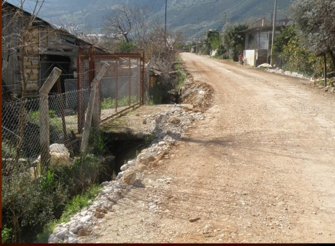
Turunçova mahallesi Delice Deresi ıslah çalışması
