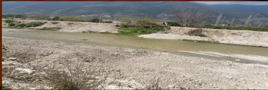
Turunçova mahallesi Akçay Deresi ıslah çalışması
