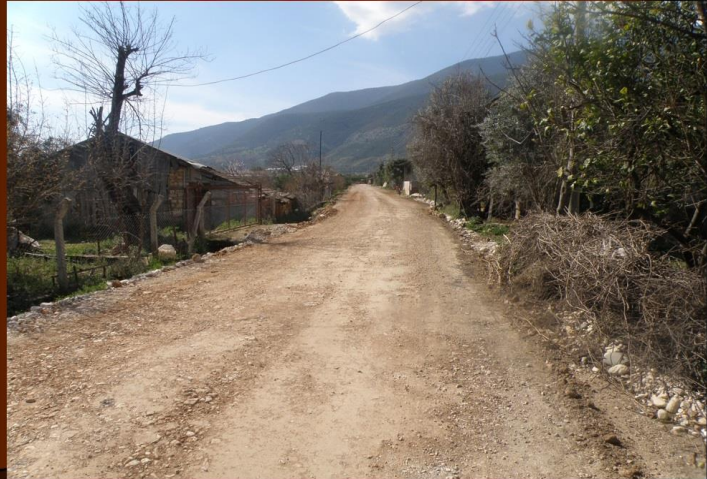
Turunçova mahallesi Delice Deresi ıslah çalışması
