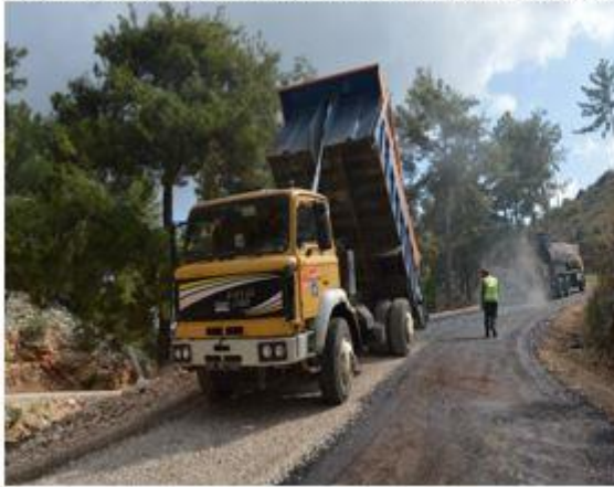
BOLDAĞ MAHALLESİ 3.5 KM ASFALT YAPIMI
